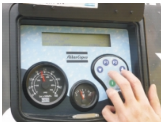
Elektronikon - řídicí systém kompresoru
